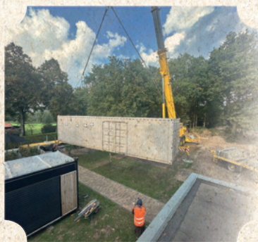
De noodkeuken wordt geplaatst.
